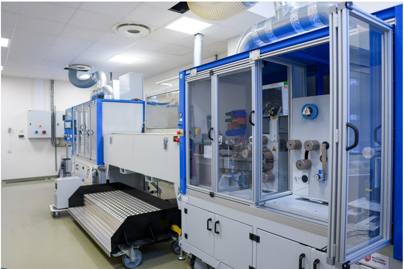
Ligne d'imprégnation composites de l'IRT Saint Exupéry à Talence
